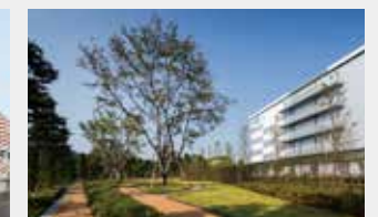
三井不動產 Logistics Park日野 (MFLP日野) 東京都日野市(2015年10月竣工)
