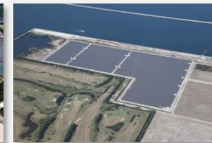
大分太陽光発電所
