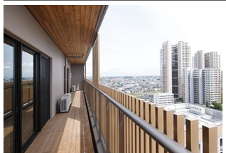
バルコニーの天井・床材 (柏の葉スマートシティ ゲートスクエア)
