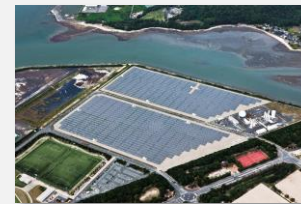
山陽小野田太陽光発電所
