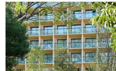
三井ガーデンホテル神宮外苑 (日光を遮るバルコニーを採用し空調効率を向上)
