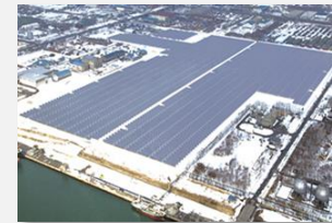
苫小牧太陽光発電所
