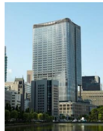
東京ミッドタウン日比谷 (「DBJ Green Building認証」と「CASBEEウェルネスオフィス認証」を同時取得)
