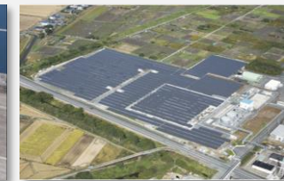
大牟田太陽光発電所
