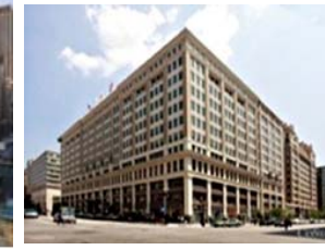
Homer Building (Washington D.C.)
