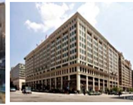
Homer Building (Washington D.C.)
