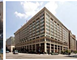
Homer Building (Washington D.C.)
