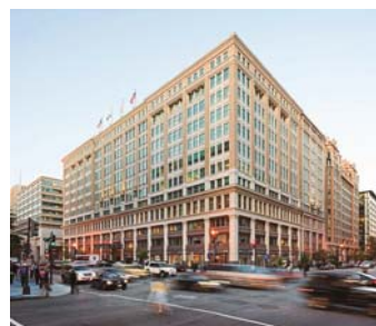
Homer Building (Washington D.C.)
