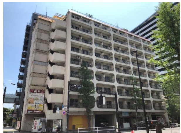
【建替え前の建物外観】
