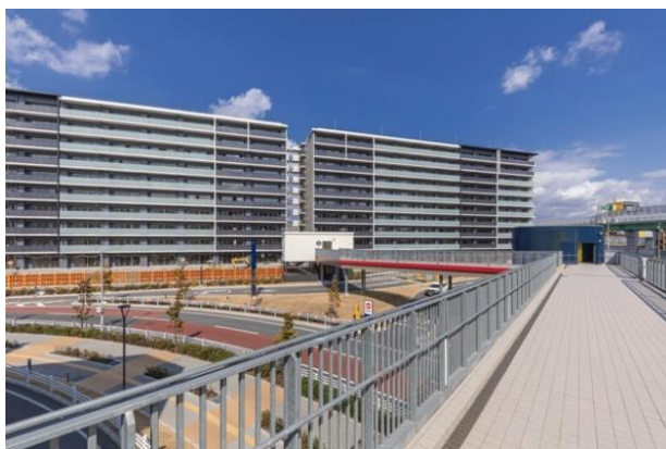
〈建物南側外観写真〉
