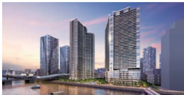
「パークタワー勝どきミッド/サウス」 (東京都中央区)
