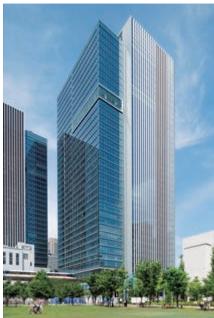
「msb Tamachi (ムスブ田町) 田町ステーションタワーN」 (東京都港区)
