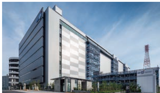
「三井不動産ロジスティクスパーク船橋Ⅱ」 (千葉県船橋市)
