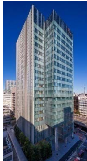
日本橋アステラス三井ビルディング
