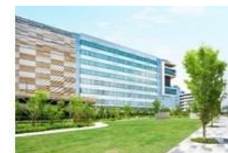
MFLP船橋・&PARK(2021年7月竣工)
