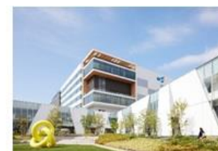
MFLP船橋Ⅲ (2021年6月竣工)
