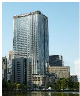
東京ミッドタウン日比谷 (2018年 竣工)
