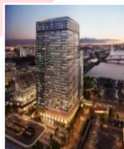
豊洲ベイサイドクロス (2020年3月,10月 竣工)
