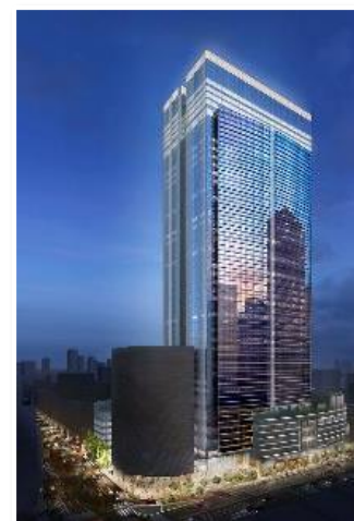
八重洲二丁目北地区 (2022年8月 竣工予定)
