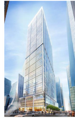
50ハドソンヤード (2022年 竣工予定)
