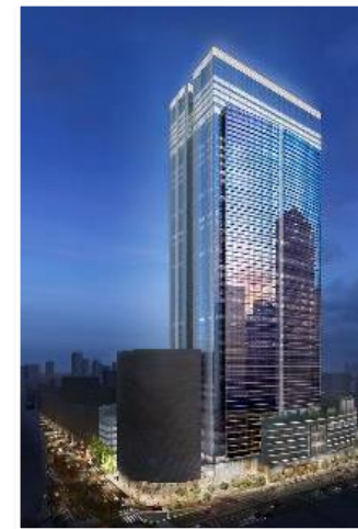
八重洲二丁目北地区 (2022年8月 竣工予定)
