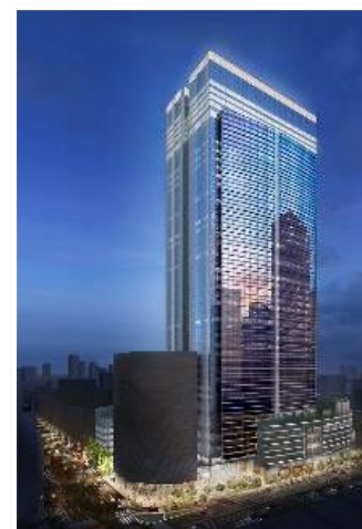
八重洲二丁目北地区 (2022年8月 竣工予定)
