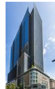
日本橋高島屋 三井ビルディング
