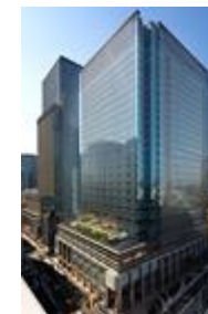
日本橋室町三井タワー
