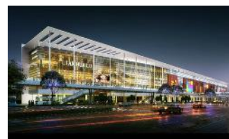
上海蓮花路駅ビル商業施設
