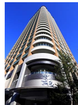
パークシティ武蔵小杉 ザ グランドウイングタワー
