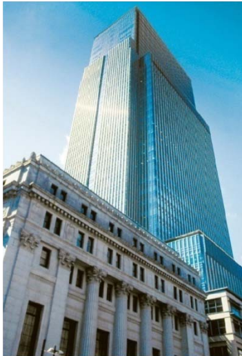
日本橋三井タワー (2005)
