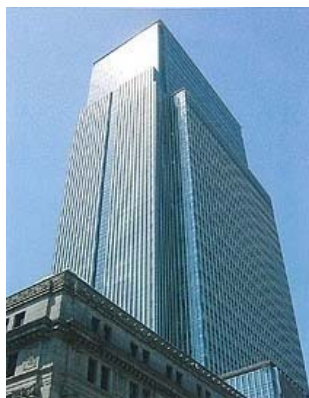
日本橋三井タワー
