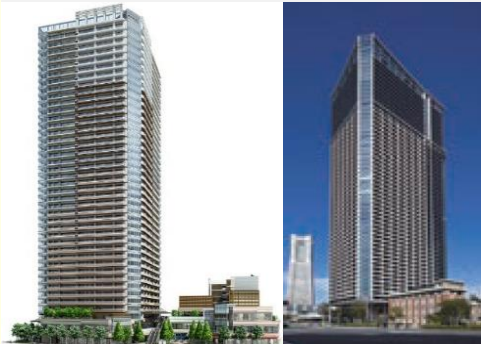
PC武蔵小山 ザ・タワー ザ・タワー 横浜北仲
