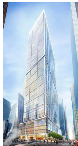
50ハドソンヤード (2022年 竣工予定)
