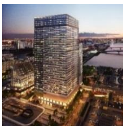
豊洲2丁目駅前地区 (2020年3月,10月 竣工予定)
