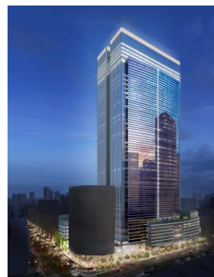
八重洲二丁目北地区 (2022年8月 竣工予定)
