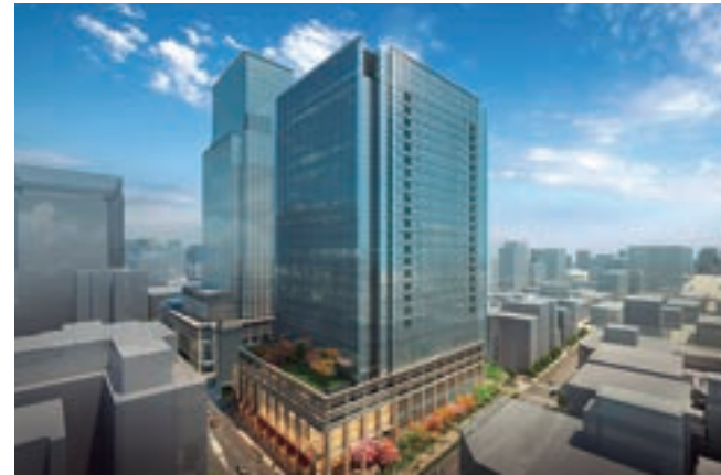
日本橋室町三丁目地区第一種市街地再開発事業 (2019年3月竣工予定/東京都中央区)
