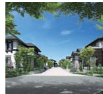
ファインコート国分寺紅葉の邸 (平成23年8月竣工) イメージパース
