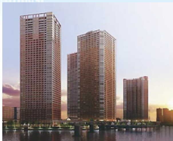
芝浦アイランド エアタワー&ブルームタワー (平成19年3月竣工・平成20年9月竣工)
