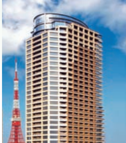
パークコート麻布十番ザタワー (平成22年5月竣工)
