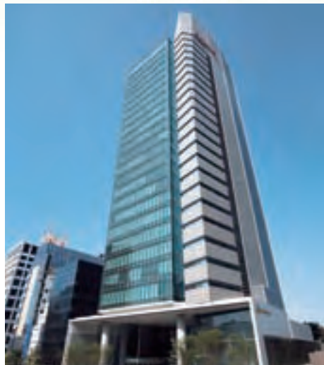
青山OM-SQUARE (平成20年7月竣工)
