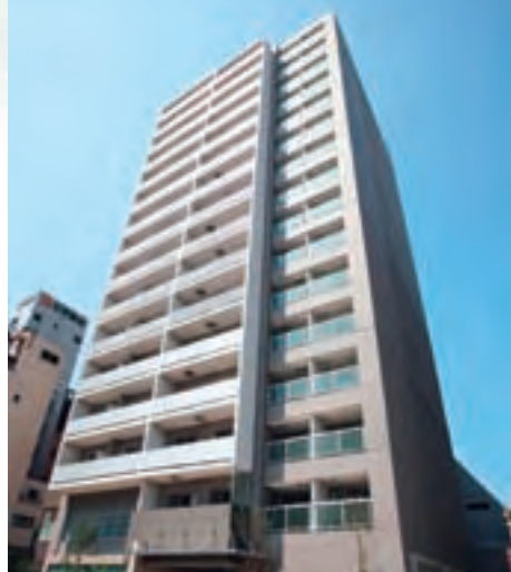
パークアクシス元浅草ステージ (平成20年4月竣工)
