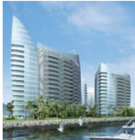
ザ・オーシャンフロント@セントーサ (平成21年夏竣工予定/シンガポール) [TID(株)] 完成予想図
