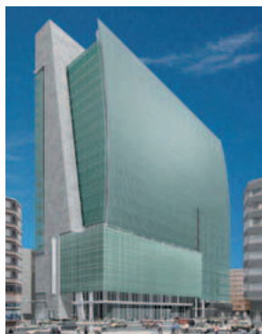
(仮称) 日本橋一丁目計画 (平成16年1月竣工予定)
