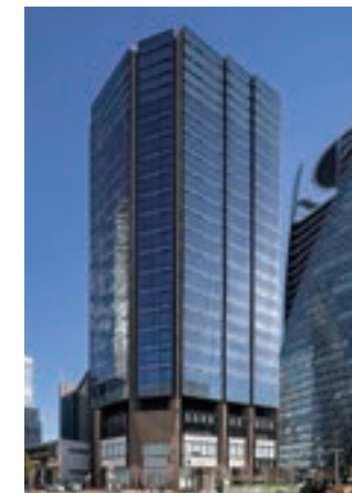
「名古屋三井ビルディング北館」(愛知県名古屋市)
