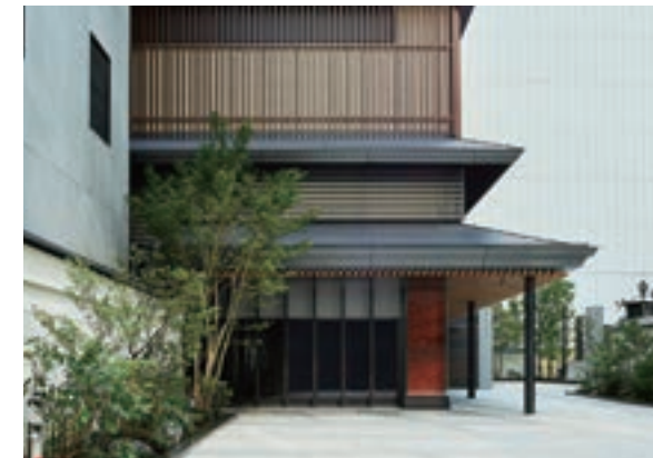
「三井ガーデンホテル京都河原町浄教寺」(京都府京都市)
