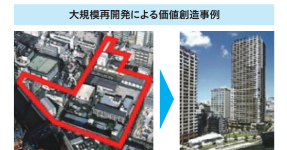
パークタワーグランドスカイ (東京都品川区、2010年竣工)
