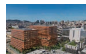
上海蓮花路駅ビル商業施設
