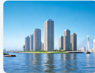
大川端リバーシティ21 西ブロック 全体竣工 (1993年)
