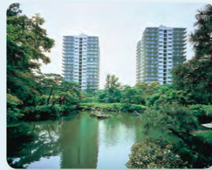
三田綱町パークマンション竣工 (1971年)
