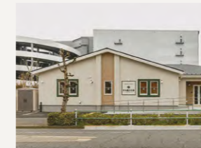
認証保育所を敷地内に設置
