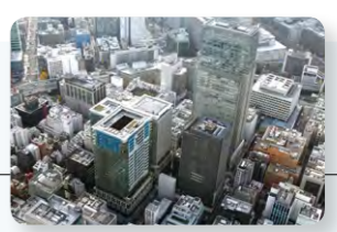
日本橋室町東地区開発計画全体竣工 (2014年)
