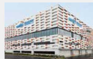
三井不動産 インダストリアルパーク羽田 (MFIP羽田) 東京都大田区(2019年6月竣工)
