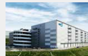
三井不動産 ロジスティクスパーク茨木 (MFLP茨木) 大阪府茨木市(2017年9月竣工)
