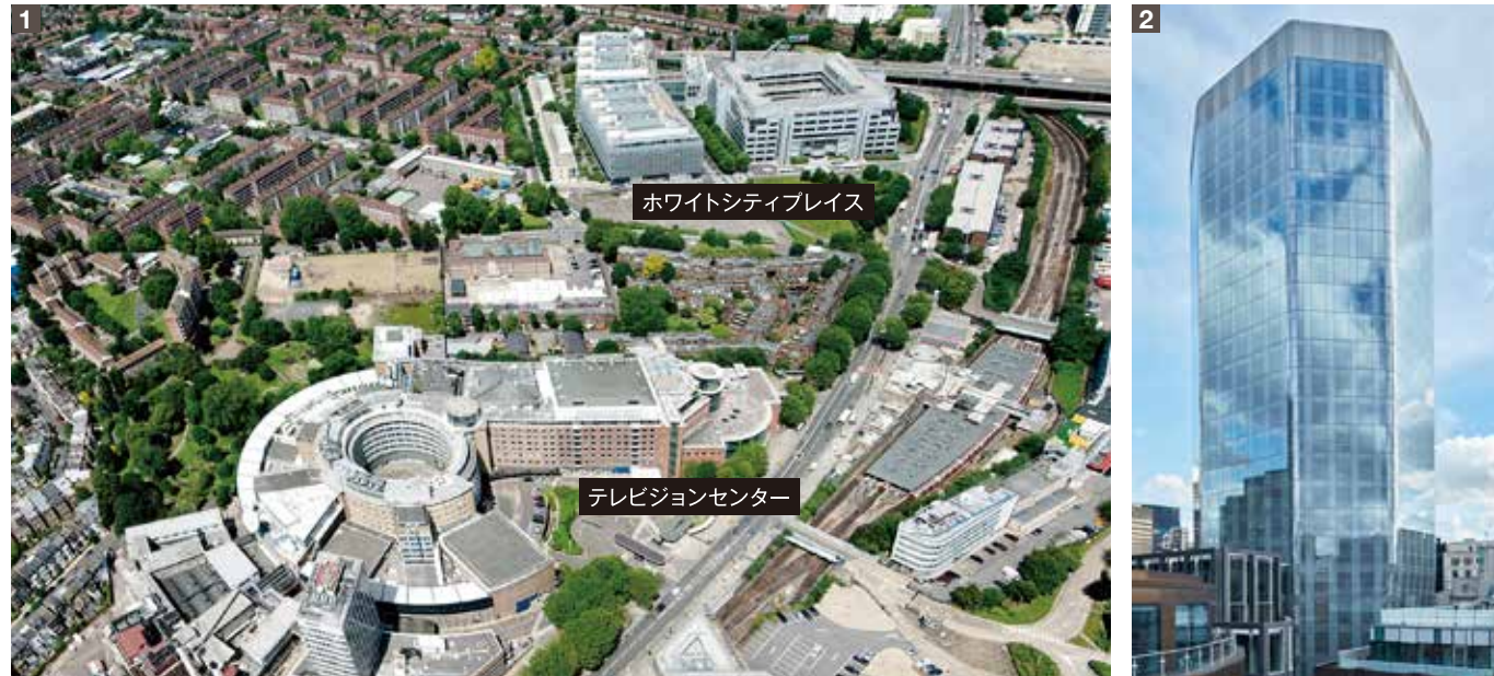
1 テレビジョンセンター再開発計画/ホワイトシティプレイス再開発計画 [オフィス/住宅/ホテル]イギリス/ロンドン (テレビジョンセンター 第1期2018年全体竣工、西オフィス棟2023年竣工予定) (ホワイトシティプレイス ゲートウェイセントラル棟2022年竣工予定) 2 1エンジェルコート [オフィス/店舗]イギリス/ロンドン(2017年竣工)
