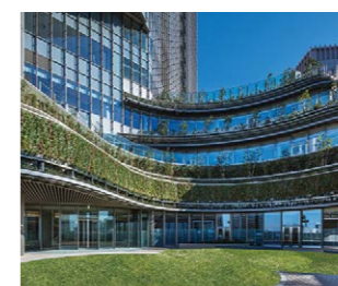
▶ 壁面・屋上緑化 「パークビューガーデン」(6階)から「スカイガーデン」(9階)へと続く壁面・屋上緑化。
