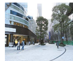
▶ 緑豊かな歩行者専用道路 千代田区道136号を緑豊かな歩行者専用道路に。日比谷公園と同種の樹木を取り入れるなど、公園から続くような緑豊かな歩行空間に。
