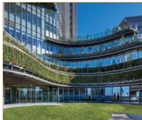
▶ 壁面・屋上緑化
