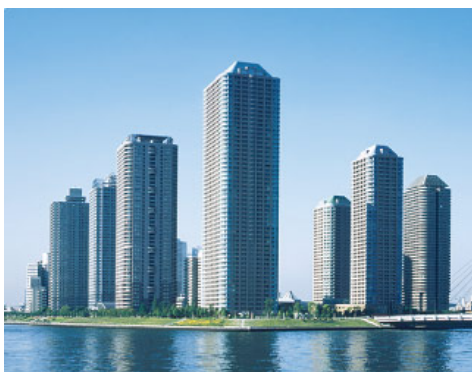
「大川端リバーシティ21」（東京都中央区）
