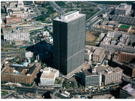
竣工当時の「霞が関ビルディング」（東京都千代田区）
