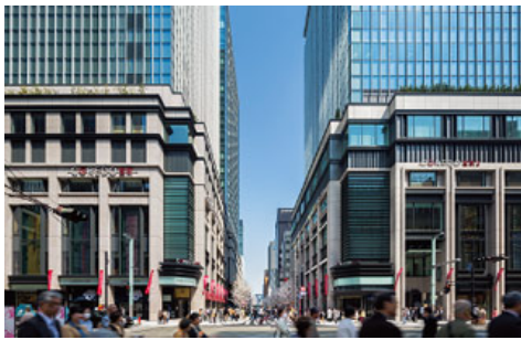
「COREDO室町1」「COREDO室町3」(東京都中央区)
