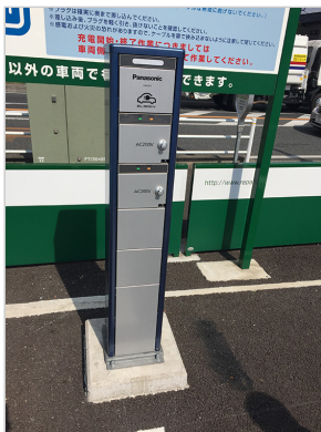
「『三井のリパーク』変なホテル舞浜 東京ベイ駐車場」（千葉県浦安市）のEV・PHV用充電器
