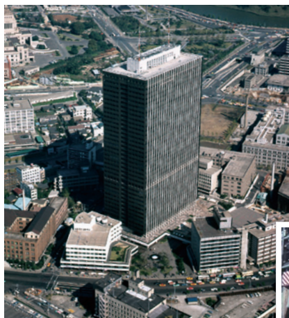
竣工当時の「霞が関ビルディング」 (東京都千代田区)
