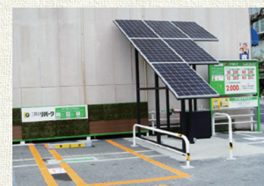
非常用電源にもなるハイブリッドソーラーシステム
