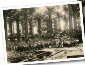
建築中の様子
