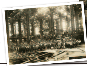
建築中の様子
