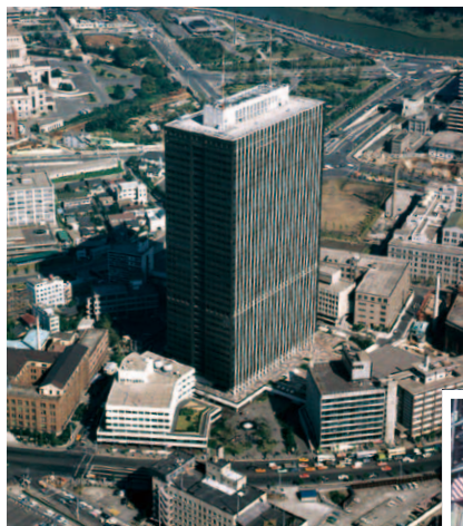
竣工当時の「霞が関ビルディング」 (東京都千代田区)
