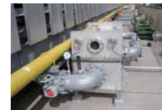
丸型光触媒浄水機(三井別館クーリングタワー用)
