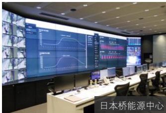
日本桥能源中心
